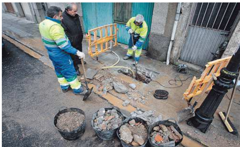
El concejal de Servicios, con personal de Aqualia, en una reparación en Francisco Moure. CARLOS CORTÉS
